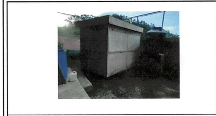
Implementacion de cocina: sustittucion de la case por cocina de block, colocacion de torta de concreto para instacion de piso, instalacion de puerta y ventanas
